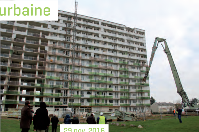
29 nov. 2016 CHÂTELLERAULT OZON Démolition de la tour T8
